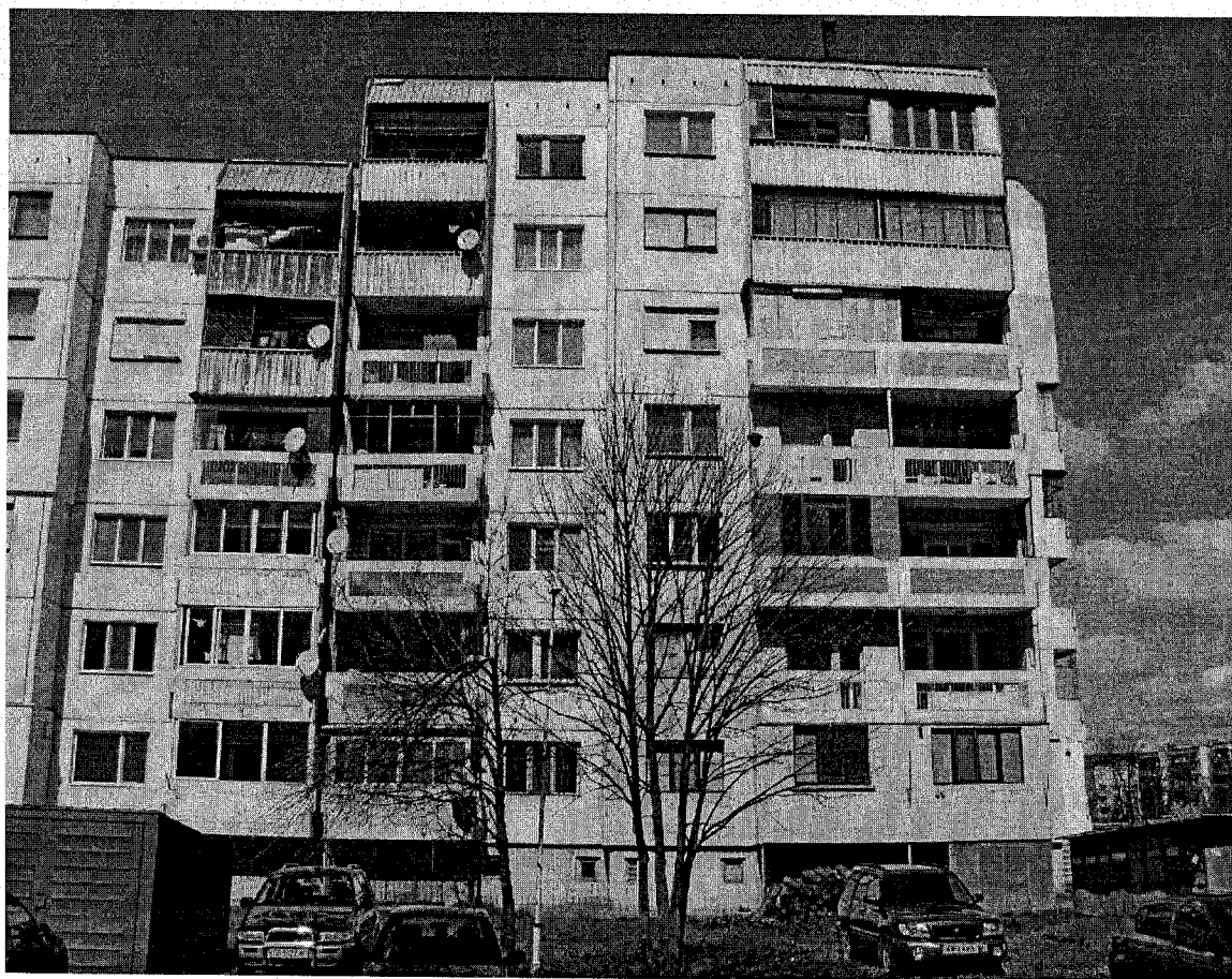
Югоизточна фасада – наличие на голям брой приобщени балкони. Частично положена топлоизолация и частично подменена дограма. Частично репарирани фуги между фасадните панели.
